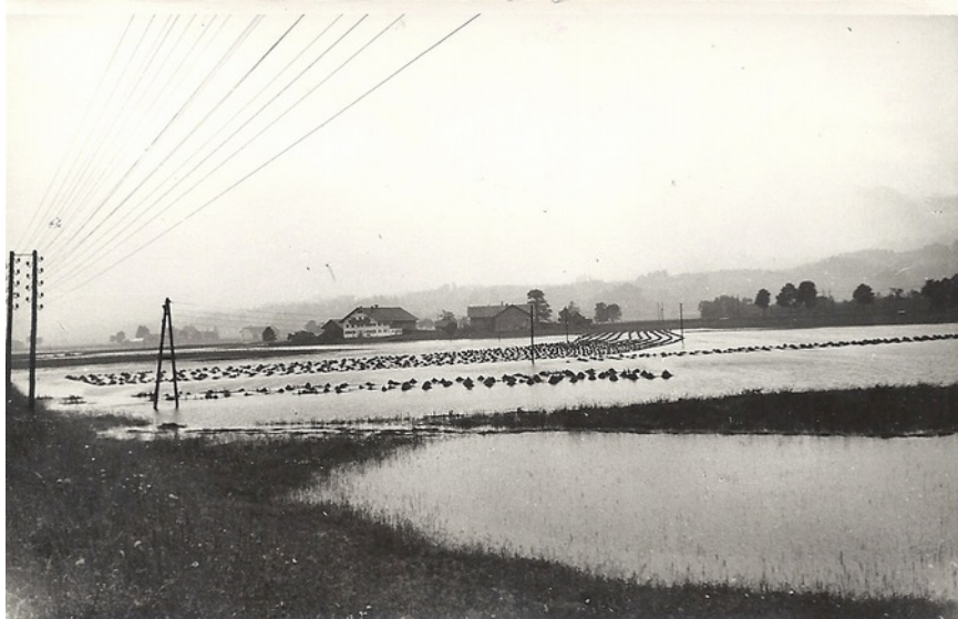
Abbildung 3: Durch Hochwasser verschmutzte Heuernte
